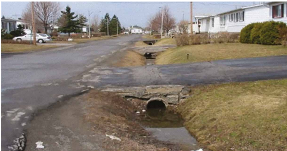
RUE LAVIGNE – AVANT
